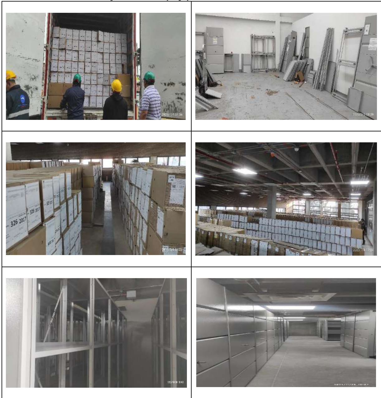
Imágen N° 68: Evidencia fotográfica traslado e instalaciones nuevas
