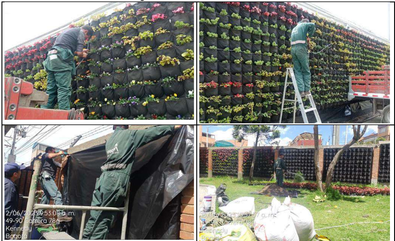
Imagen 43. Instalación de muros verdes
